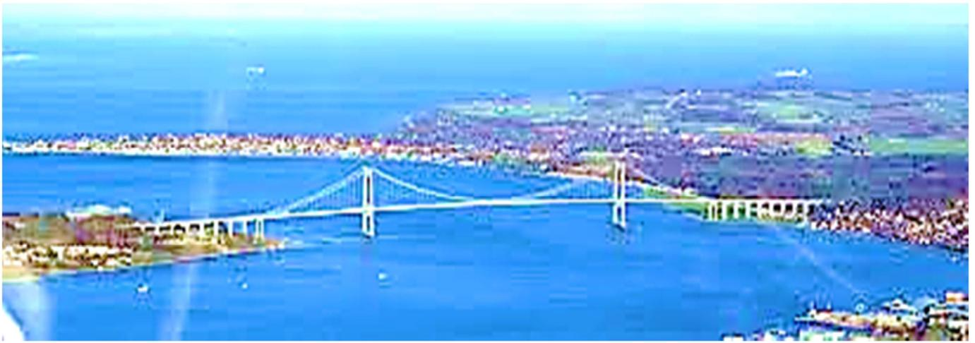
Einsatz, der hier geleistet wurde, wenn man im Auto den Großen Belt überquert. Die Anlage umfasst die Ostbrücke (eine Hängebrücke), die Westbrücke (eine Niederbrücke) und den Osttunnel (ein gebohrter Tunnel) für die Eisenbahn. Die Brücke verbindet die dänischen Landes- teile und erleichtert den innerdänischen Verkehr erheblich. Dank dem
